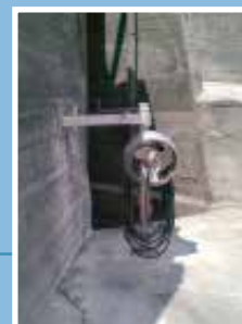
Installazione di miscelatore sommerso tipo MX-gi con anello convogliatore. Installation of a submersible mixer type MX-gi with conveyor ring.
