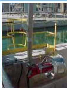
Installazione di miscelatore sommerso tipo MX-gi con anello convogliatore. Installation of a submersible mixer type MX-gi with conveyor ring.
