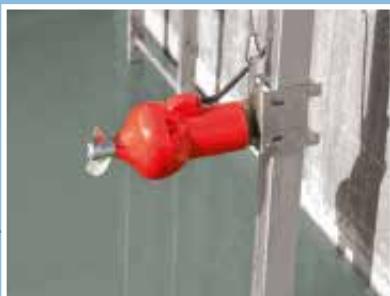
Fasi di installazione di miscelatore sommerso tipo MX-gi. Installation stages of a submersible mixer type MX-gi.
