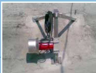
Installazione di miscelatore sommerso tipo MX-gi con anello convogliatore. Installation of a submersible mixer type MX-gi with conveyor ring.
