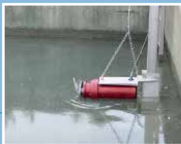
Fasi di installazione di miscelatore sommerso tipo MX-gi. Installation stages of a submersible mixer type MX-gi.
