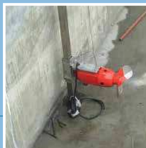
Installazione di miscelatore sommerso tipo MX-GIR. Installation of a submersible mixer type MX-GIR.
