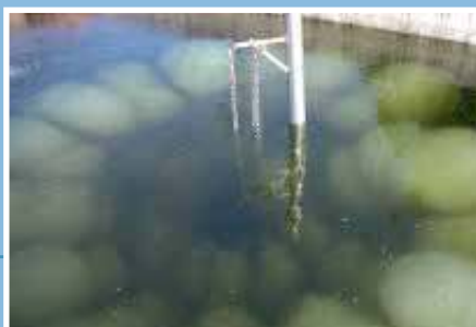
Fasi di avviamento di aeratore sommerso radiale. Starting stages of a radial submersible aerator.
