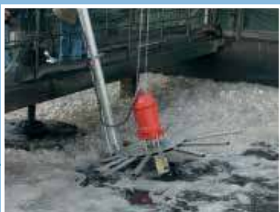
Fasi di installazione di aeratore sommerso tipo SCL. Installation stages of a submersible aerator type SCL
