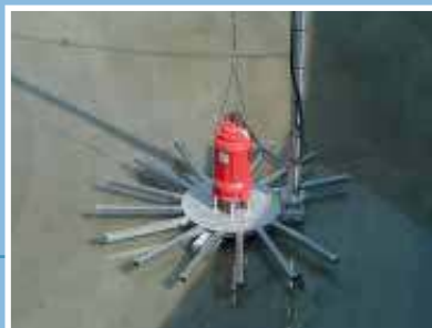
Installazione di aeratore sommerso tipo SCL Installation of a submersible aerator type SCL
