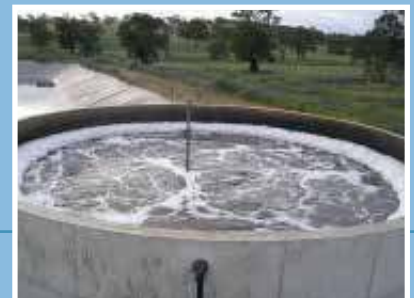
Installazione di aeratore sommerso tipo SCL. Installation of a submersible aerator type SCL
