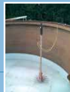
Installazione di aeratore sommerso tipo SCL Installation of a submersible aerator type SCL
