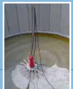
Installazione di aeratore sommerso tipo SCL Installation of a submersible aerator type SCL
