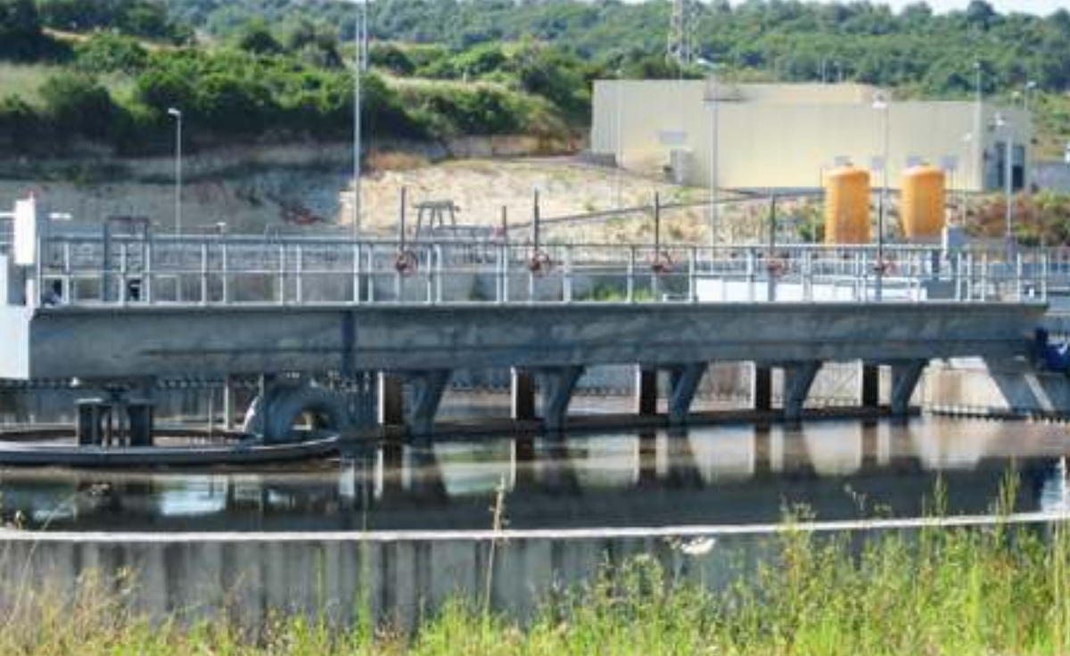
05-091 Ponte sedimentatore circolare aspirato a trazione periferica.
